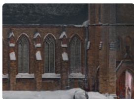
Архитектурные обмеры и обследования
